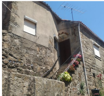
Estores externos, antena, reboco sobre alvenaria de pedra
