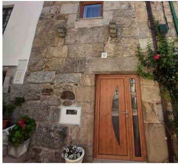
Caixa de contador, grelha de ventilação, porta, caixilharia fora da paleta
