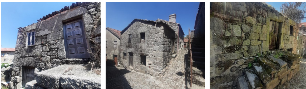
Figura 21. Exemplos de edifícios em estado crítico de conservação na ARU
