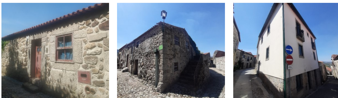
Figura 23. Exemplos de volumetria do edificado da ARU
