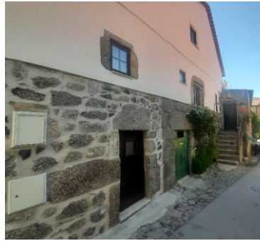
Caixas de contadores, reboco sobre alvenaria de pedra, juntas avivadas
