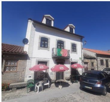
Mansarda na cobertura, cantarias, reboco fora da paleta, antena, soco
