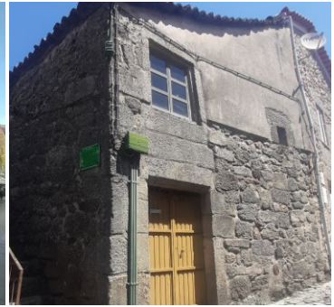
Caixilharia fora da paleta, fios e cabos elétricos, reboco sobre alvenaria de pedra, porta
