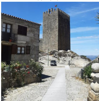
Laje de granito sob a via
